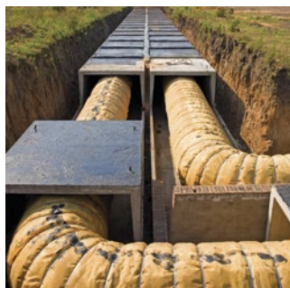
Трубопроводы под изоляцией
