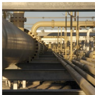
Опоры трубопроводов
